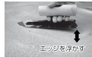
塗り付けた後、鏝のエッジ部分を浮かし、先端部分の面を塗面に付け、手前方向に鏝を滑らせるようにしてラフ模様を付けます。ラフ模様を付けた後、前記のスポンジ仕上げを行うとマイルドなラフ仕上げとなります。
