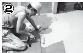
着色下地材原液をウールローラー、または刷毛を用いて、約120g/㎡を目安として塗り広げます。
