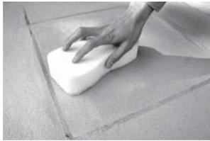
ある程度平滑に塗りつけた後、表面の平らなスポンジで塗面を数回叩いて仕上げます。洗車用などの大きめのスポンジを使用すると作業がはかどります。
