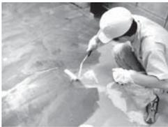
プライマー原液をローラー、または刷毛を用いて、セメントモルタル下地にしみ込むように規定量を塗布します。
