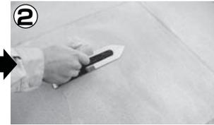
塗り付けた後、塗面に少量の霧吹きをして仕上げ鏝で平滑に仕上げます。
