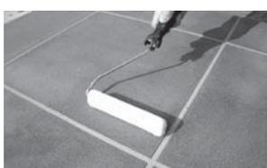
●上塗材乾燥後、または目地材除去後(目地補修した場合は、補修箇所が乾燥後)、「トップコート」をウールローラーや刷毛を用いて塗り広げます。約90g/㎡を目安として塗布します。
