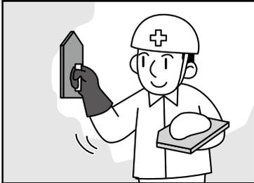
● 上塗材を塗布する直前に、下塗材を金鋺で下地へ均一に塗布します。
