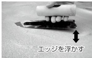
塗りつけた後、鍔のエッジ部分を浮かし、先端部分の面を塗面に付け、手前方向に鍔を滑らせるようにしてラフ模様を付けます。ラフ模様を付けた後、前記のスポンジ仕上げを行うとマイルドなラフ仕上げとなります。
