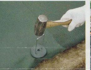
防草ワッシャー®にコ型止めピン/L型止めピンをセットし、直接ハンマーで打ち込む。
