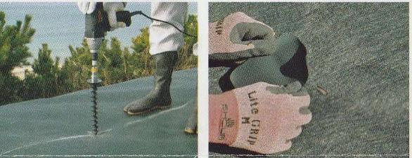
インパクトレンチ(ソケット17mm使用)でピンをシートに直接ねじ込み、上から防草パッチ®を貼る。
