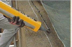
接着面の汚れを除去し、先端を口径約8mmにカットしたボンドをシート下に差し込んで注入する。シートとボンドを馴染ませ、養生する。
